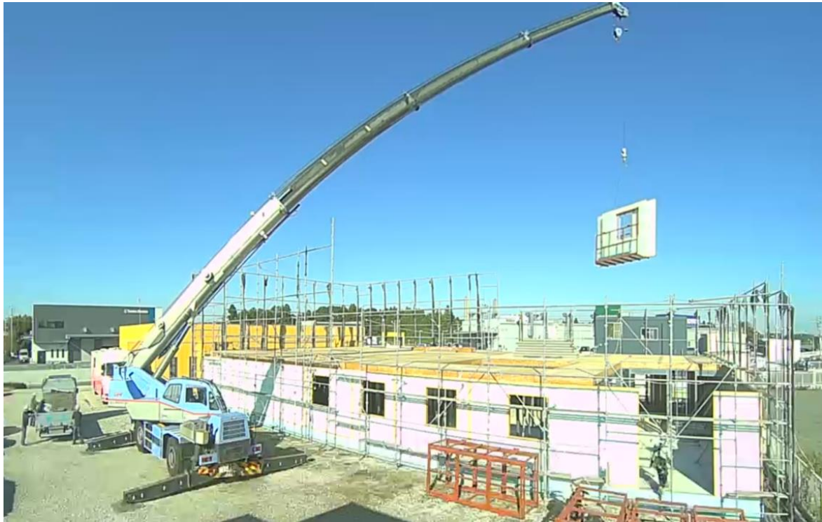
■CFS 建築で、工場で製作したパネル（2×4 スチールハウス）をクレーンでつり上げている様子（2023 年秋撮影）
