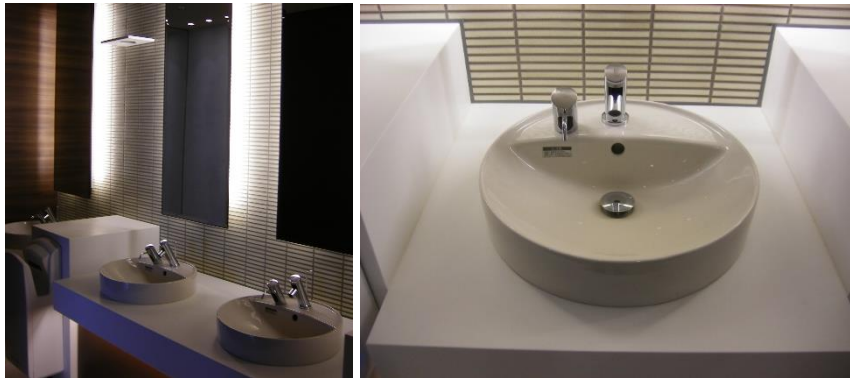
■商業施設内のトイレでの設置例（2010年）
