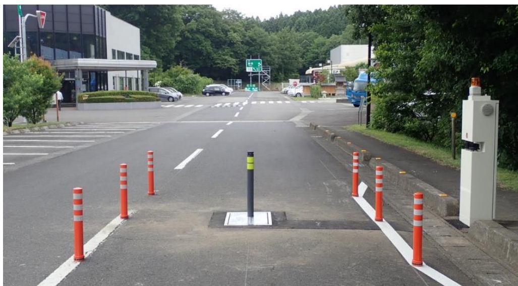
■弊社那須工場に設置した「自発光ソフトライジングボラード」
