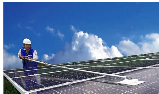
図 2-13 点検作業の様子(2)
