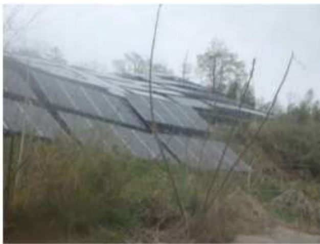
図 4-5 急傾斜地への設置
