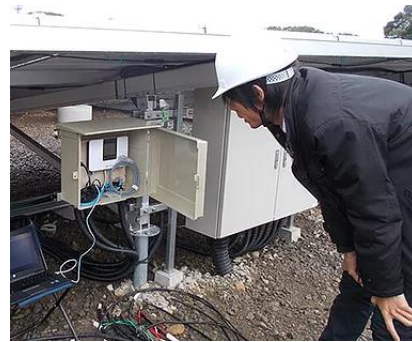
図 2-12 点検作業の様子(1)
