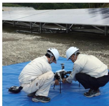
図 2-8 太陽光発電設備点検時のドローン活用の様子
