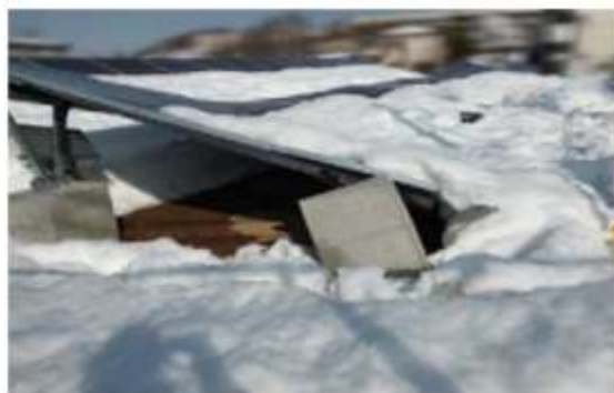
図 4-13 積雪荷重が設計を超えたため、基礎沈降した太陽光パネル
