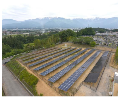
図 2-5 リュースモジュールを用いた発電所
