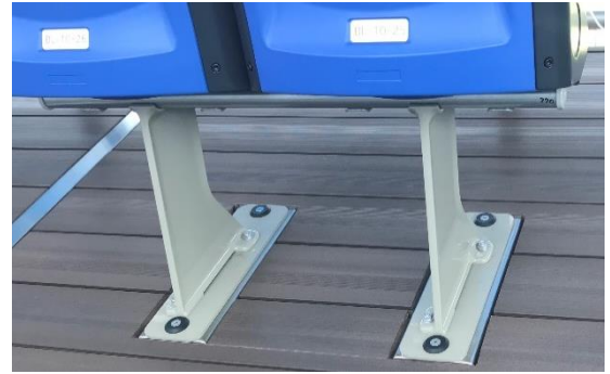
■左：施工の様子(溝を作ってステンレスパイプを設置)、右：ステンレスパイプの上に設置された取り外し式の椅子の脚部を拡大
